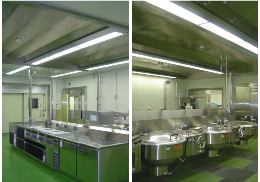
図 1 換気用天井システム施工事例 (出典: Halton社HP http://www.halton.co.jp )
