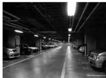
泡消火設備が設置されている 駐車場のイメージ
