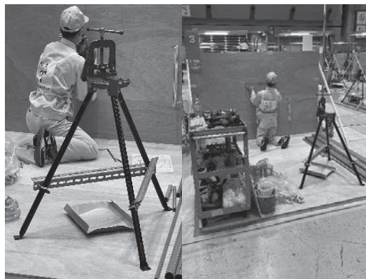
配管作業中の陽君と山岸君
