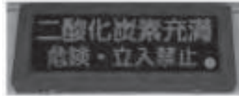
ガス消火剤放出表示灯
