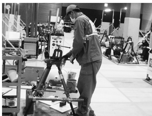
愛知で配管作業中の吉原君
