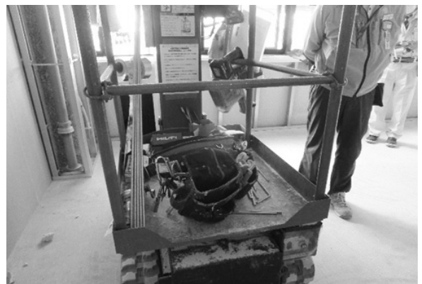
③高所作業車の床上に資材が散乱していたので、整理するよう指示しました。
