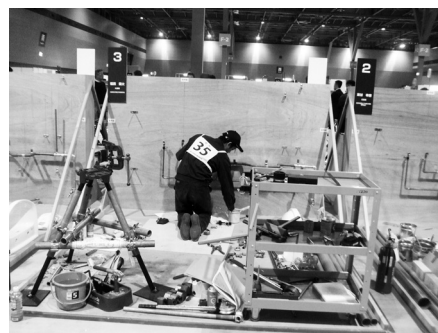
愛知で配管作業中の福西君
