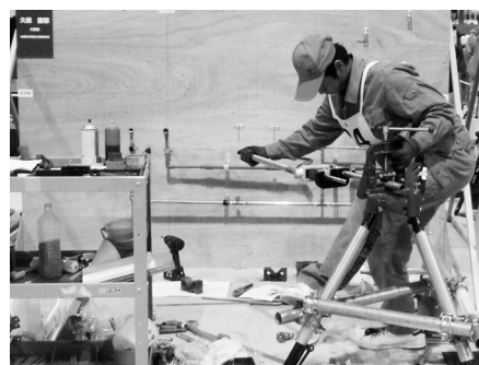
愛知で配管作業中の久保君
