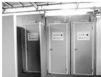
シャワー室を設置
