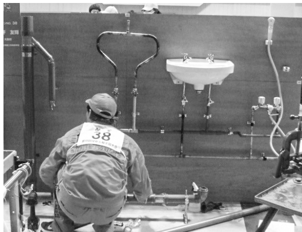
配管作業中の高坪君
