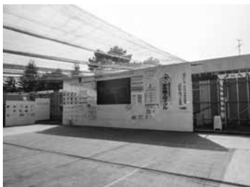
朝礼場に人工芝を張り詰め、遮光ネットを取り付けて熱中症対策
