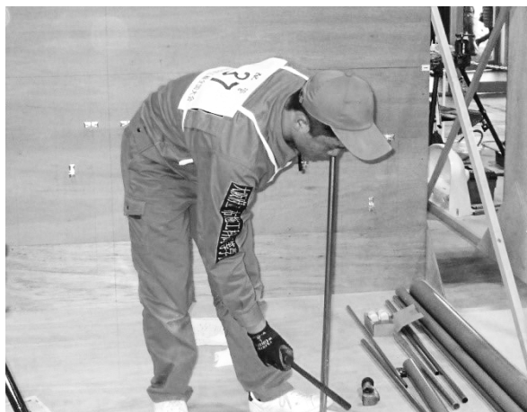
配管作業中の金沢君
