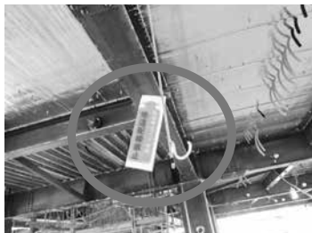
地這配線防止用フックの設置
