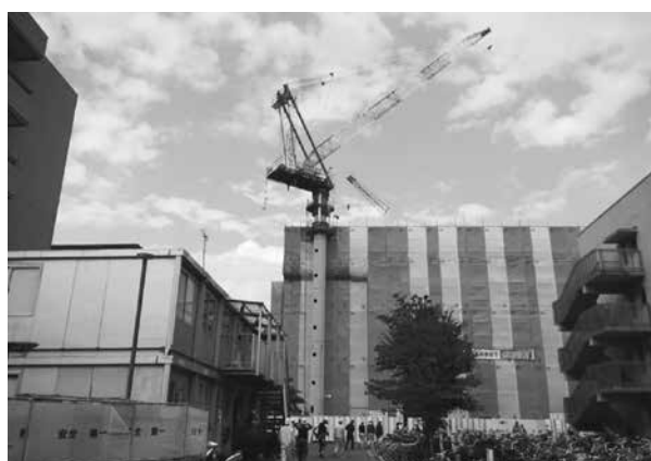
南側からの現場風景
