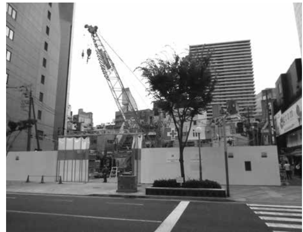
ホテルの建設現場
