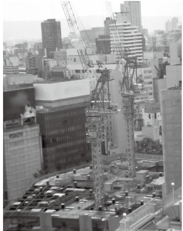
梅田1丁目1番地計画地ではタワークレーンによる低層部の鉄骨建方工事が進んでいる
