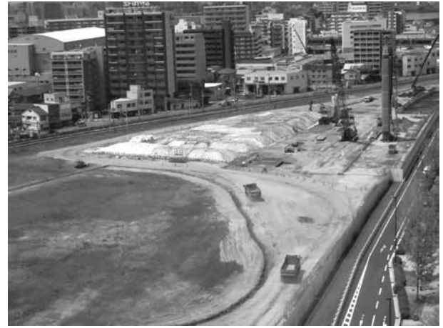
土砂運搬トラックが盛んに行き交う開削工事現場
