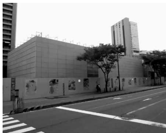
梅田3丁目計画地ではビルの撤去工事が進行中
