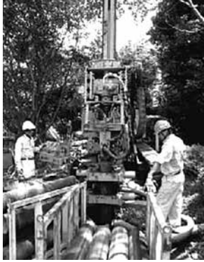
ボアホール掘削
