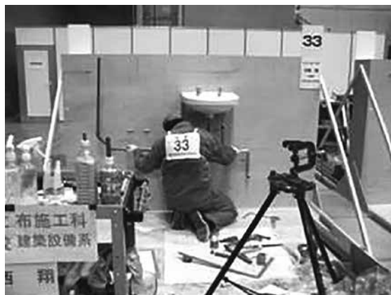
配管作業中の小西君
