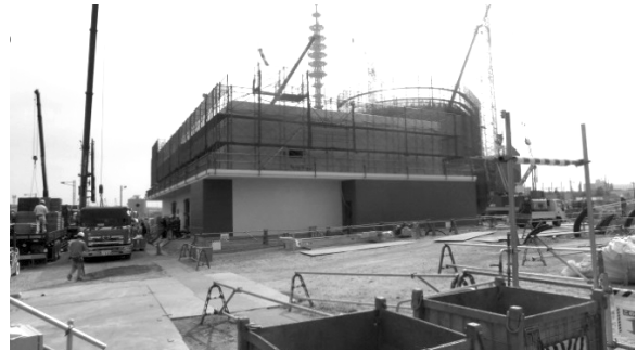
東側より副試験棟
