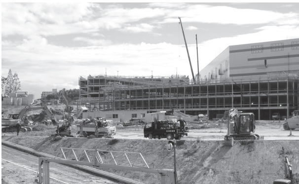
急ピッチで建設中の立体駐車場 (右奥はレストランや各種ショップが集結する大型施設「ららぽーとEXPOCITY」)
