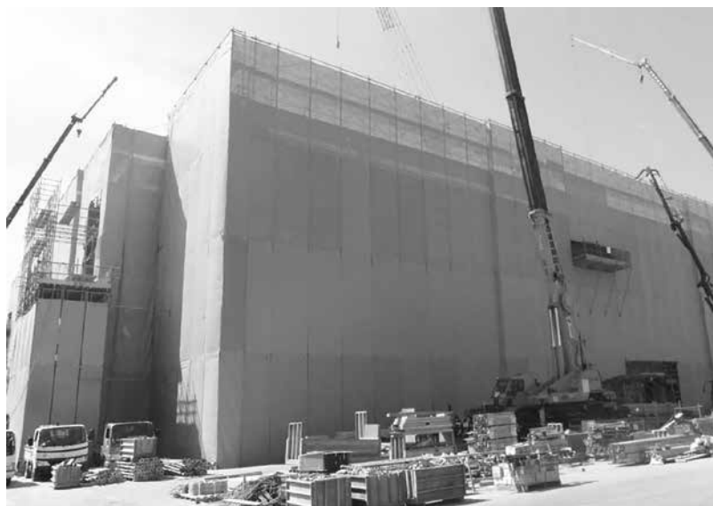
北西側からの施工進捗状況
