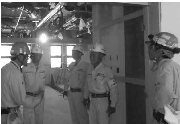
各実験室内天井配管ダクト施工状況
