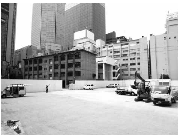
一部工事が始まった現場（正面左奥が校舎）
