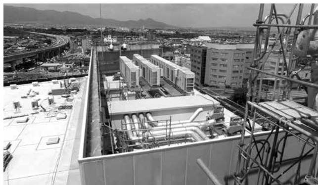
上空から見た建設現場
