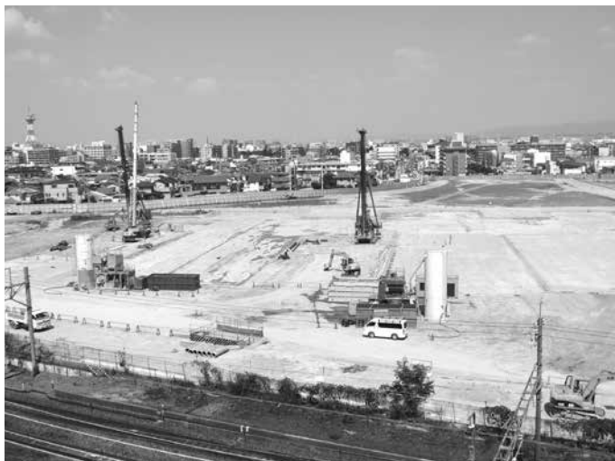
開発地北側・東側（学舎と防災公園予定地）
