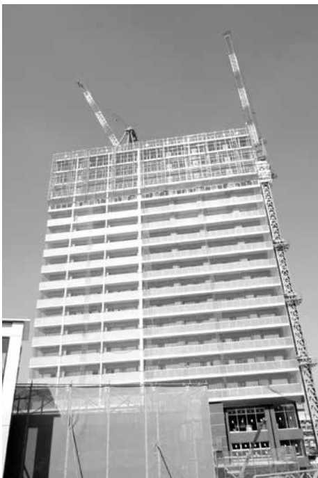
来年竣工予定の高層マンション
