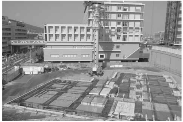
複合施設棟も基礎工事が始まった
